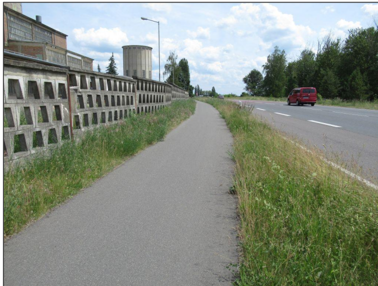
Abbildung 17: Radweg und Bundesstraße
