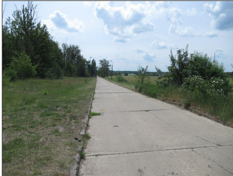
Abbildung 16: betonierte Zufahrt zum Betriebsgelände
