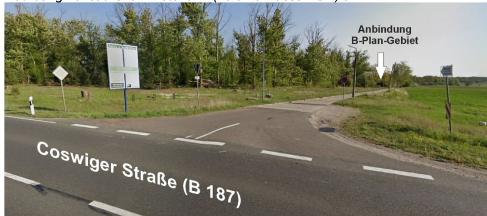
Abbildung 10: südlicher Knotenarm (Zufahrt Wasserwerk) am KP 1
