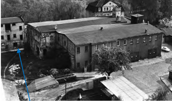
Reste der ehemaligen Papierfabrik, erbaut auf der Stützwand
