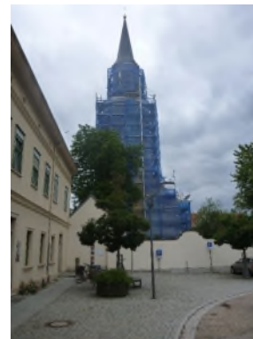
Bauarbeiten am Kirchturm
