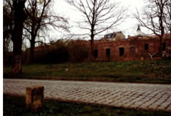
Südlicher Ortseingang zu Beginn der Sanierungsmaßnahme
