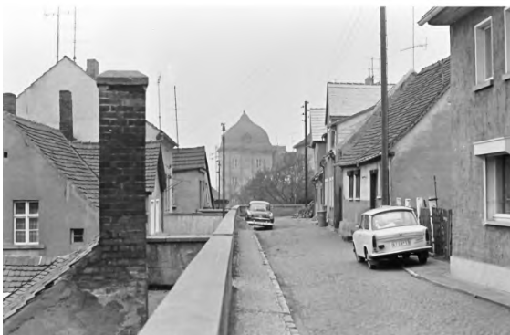
Oberfischerei zu Beginn der Sanierungsmaßnahme:
