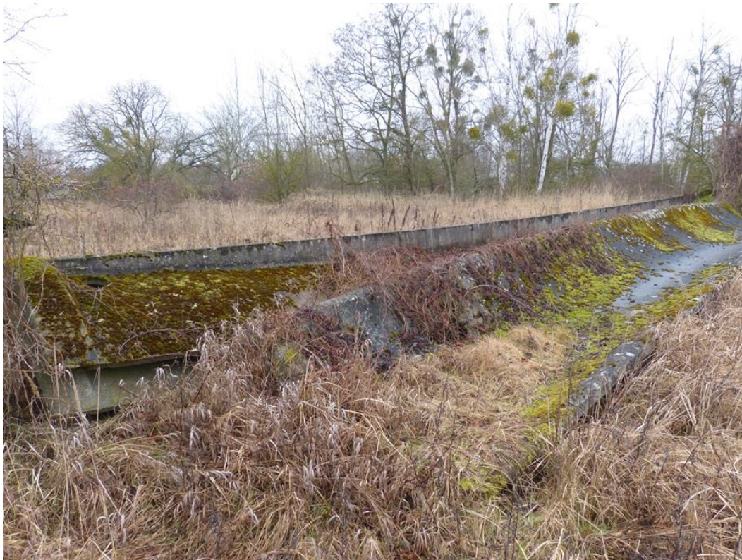
Bild 7: Beton-Halbschalen im Südteil
