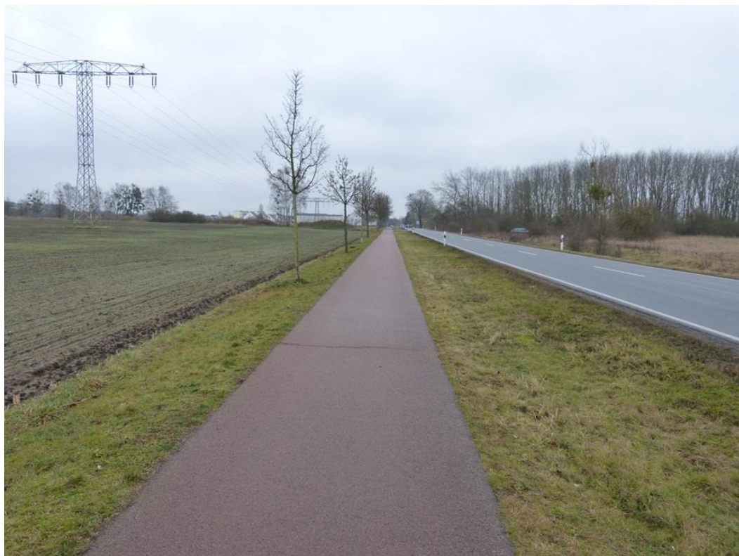
Bild 10: Blick entlang der Ostseite des Plangebiets auf Ziekoer Straße mit Radweg
