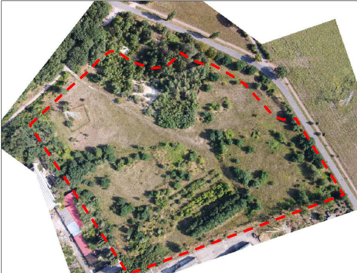
Abb. 3: Drohnenluftbild vom Plangebiet (rote Strichlinie) (IB Hauffe GbR, Juli 2023).
