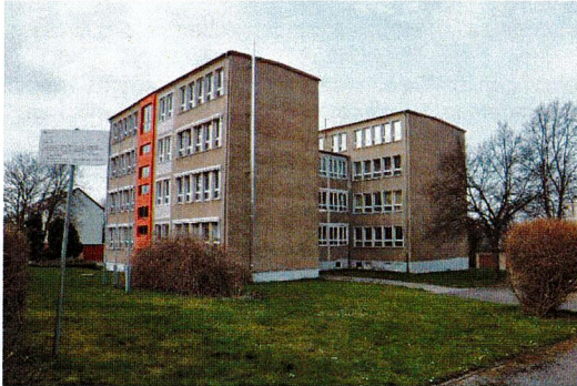
Beispiel: GS „Dr. Schmidt“ in Wegeleben vor der Sanierung
