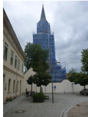
Bauarbeiten am Kirchturm
