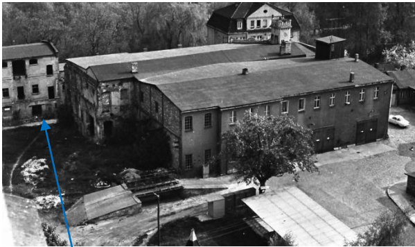
Reste der ehemaligen Papierfabrik, erbaut auf der Stützwand
