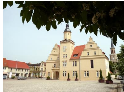
Marktplatz mit saniertem Rathaus
