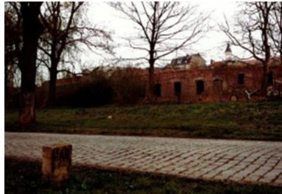
Südlicher Ortseingang zu Beginn der Sanierungsmaßnahme
