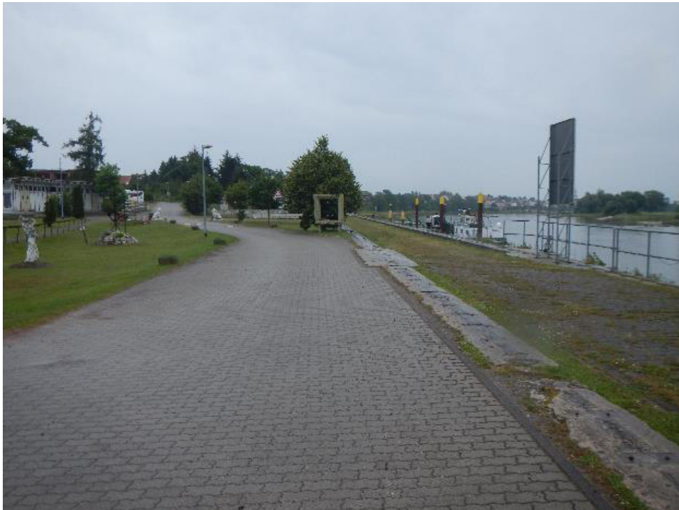
Abbildung 4: Östlicher Bereich des B-Plangebietes (Blickrichtung West – Ost)
