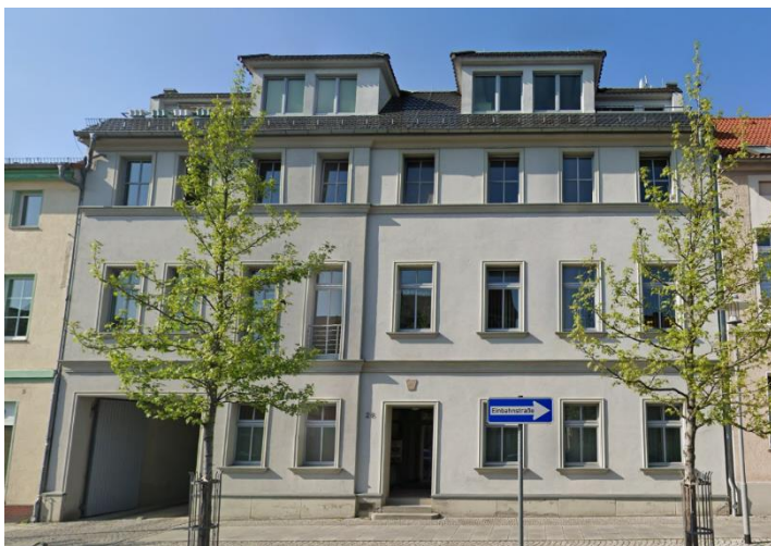
unzulässige Dacheinschnitte in der Schloßstraße
